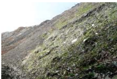
工事前(斜面荒廢状況)
