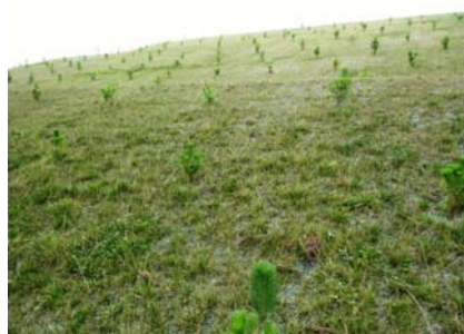
工事後(斜面植生復元状況)
