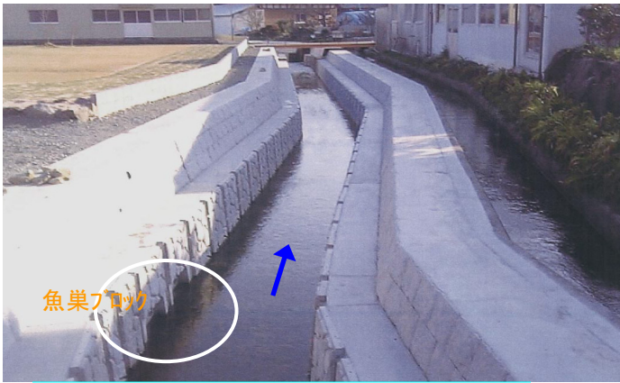
水路整備後／除草作業省略・生態系改善
