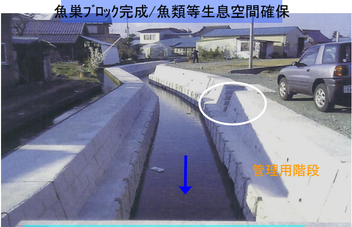
水路整備後／管理用階段・維持管理向上
