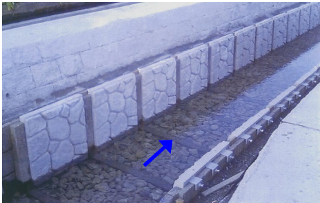
化粧パネル取付／河床礫敷設
